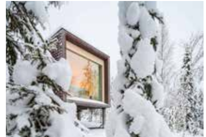
Instalaciones nórdicas (cargas pesadas de nieve y hasta -15 °C)
