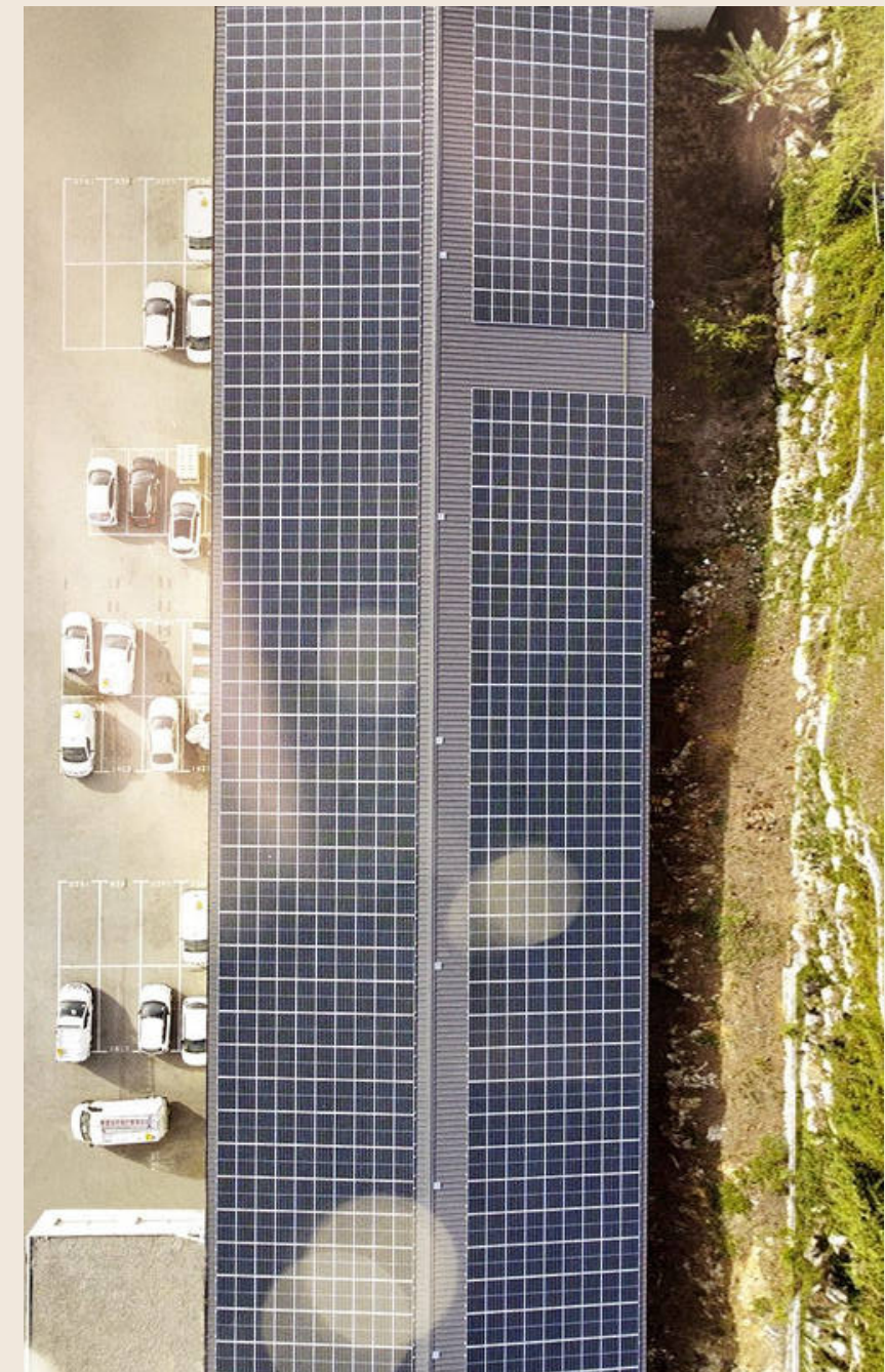
300 KW Energies des Territoires Commercial Solar Rooftop, France
